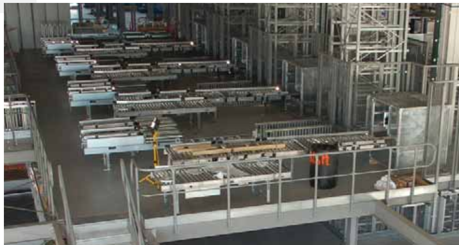
12.000 metros quadrados de ResinDek ® LD 50 instalados em um armazém no Canadá.
